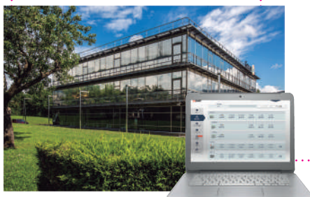
Sistema de gestão de edifícios (BMS)
